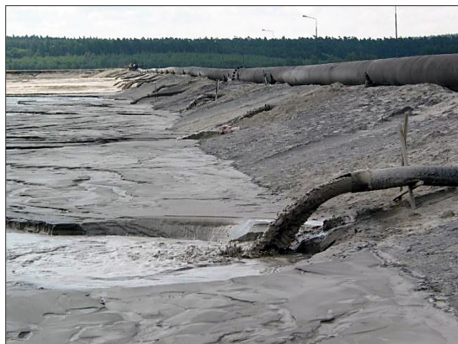
Rys. 2. Obserwowana strefa rozmycia w miejscu zrzutu odpadów [Tschuschke 2006]
