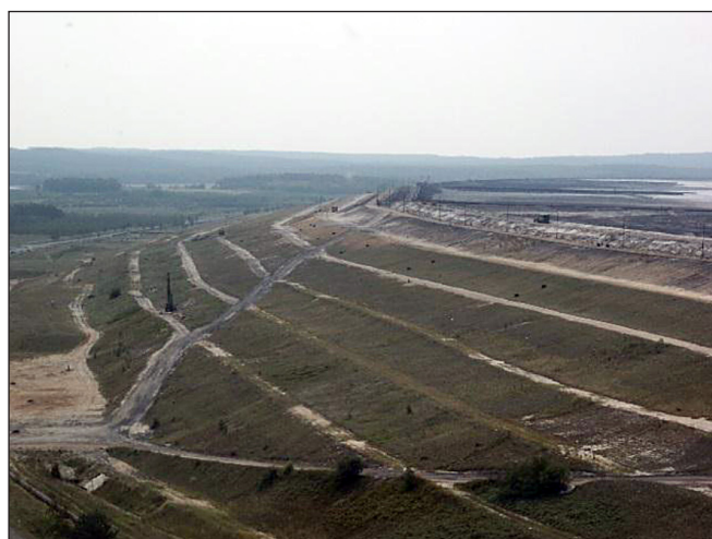
Rys. 3. Widok na obwałowania zapory wschodniej OUOW Żelazny Most [Tschuschke 2006]
