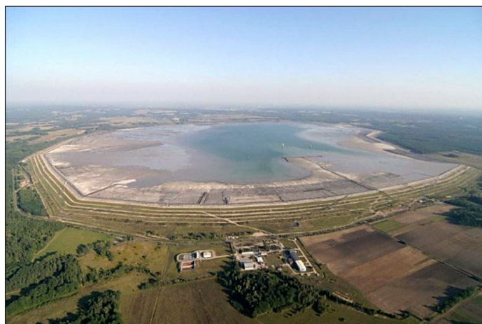
Rys. 1. Ogólny widok na OUOW Żelazny Most [Jamiołkowski 2014] Fig. 1. The general view of the OUOW Żelazny Most [Jamiołkowski 2014]
